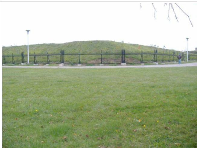
4 hectares de potentiel perdu... (construction de la clôture entourant le réservoir 3A de l'usine de filtration Atwater, vue de Verdun, qui était auparavant un espace ouvert)
